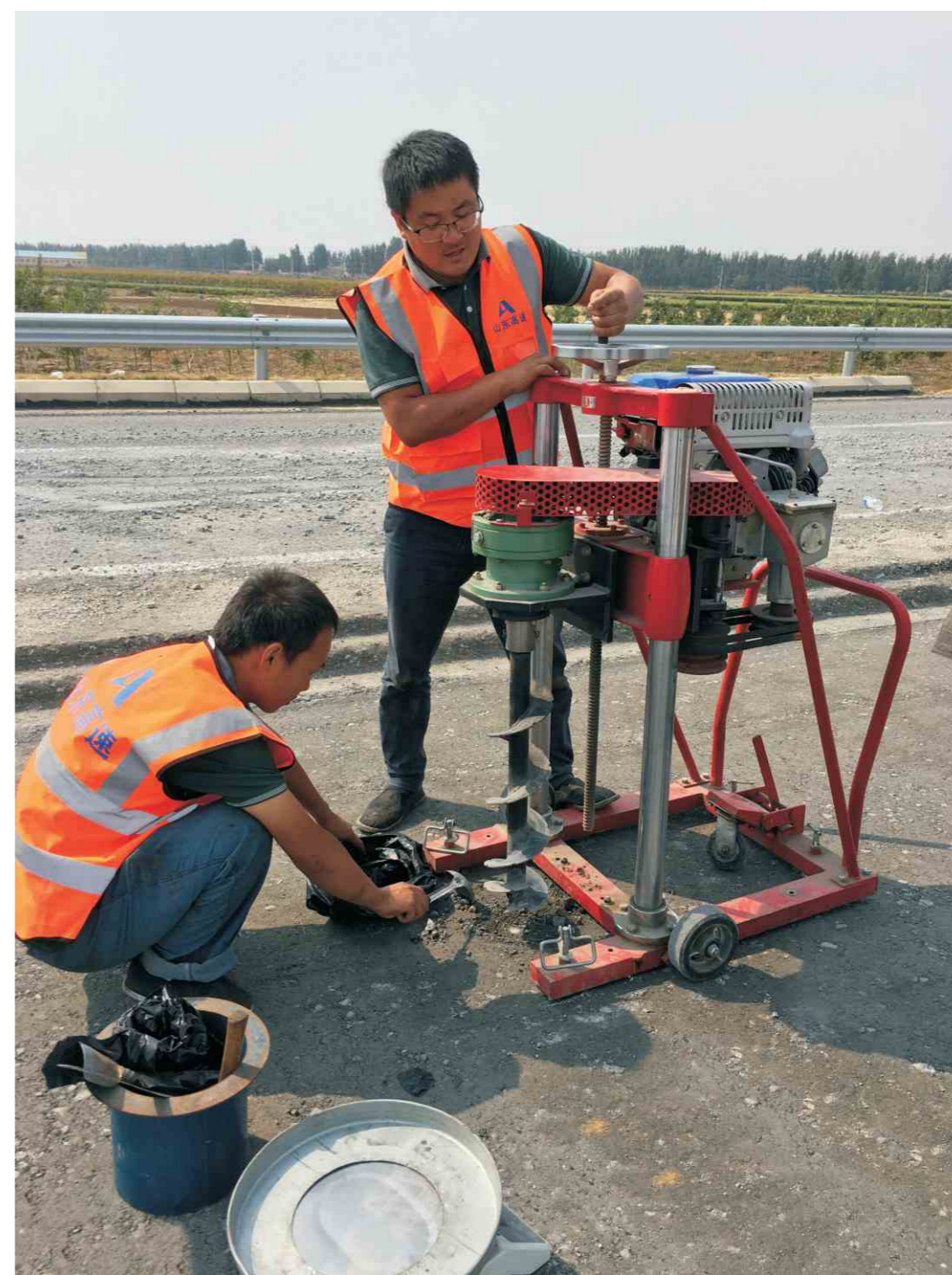
用于测试超厚度压实度的挖坑机
