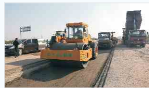
39t大吨位压路机初压
